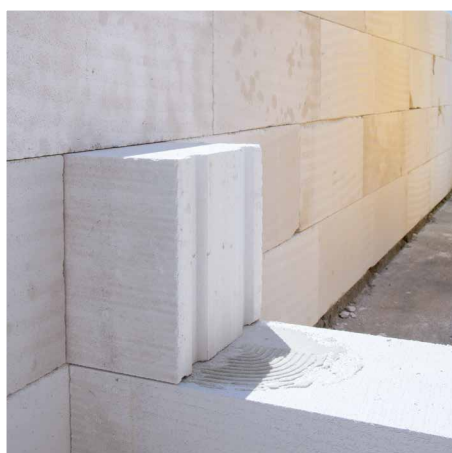
Detail väzby vnútornej a obvodovej steny.
